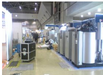
設置したブースは地震で倒壊
